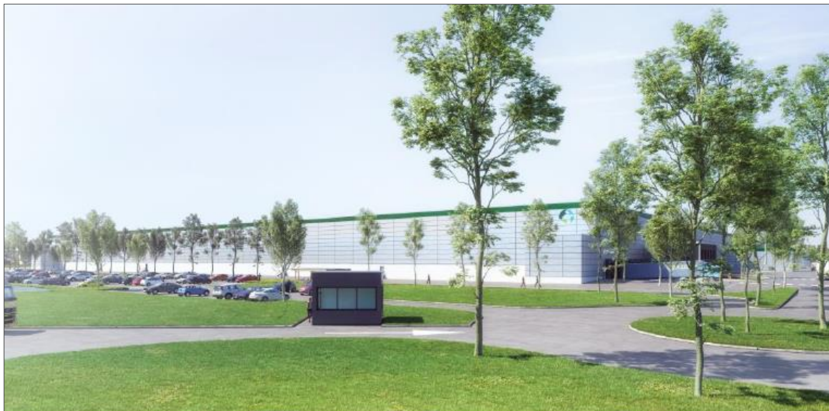
Figure 33 : Vue depuis l'entrée du site PROLOGIS
